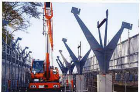
上/保育室 中・下/施工時の様子
