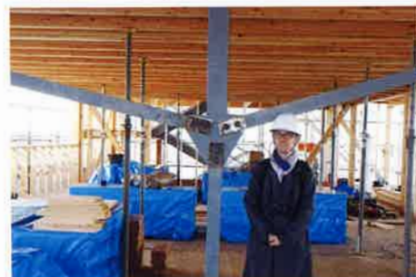
上/LVLの梁とスチールの柱* A 下/スチールプレートと構造設計を担当したリズムデザイン=モヴ ー級建築士事務所の中田氏* B
