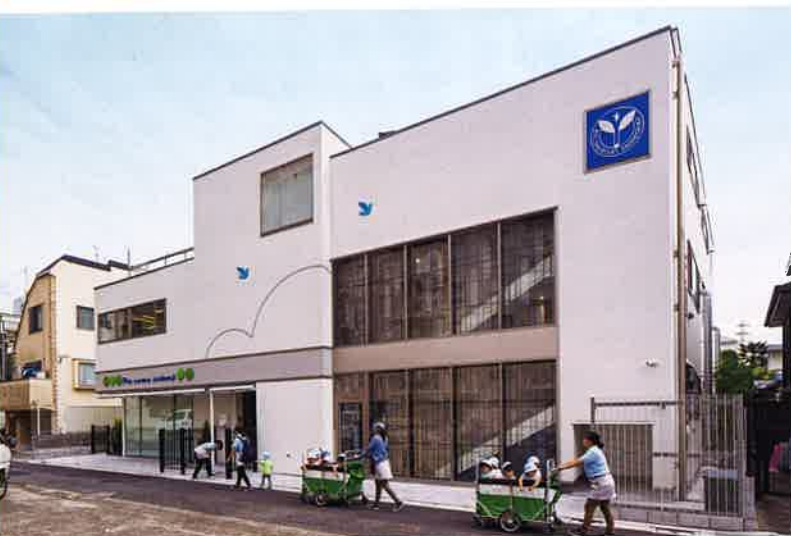
上／園庭より見る 左下／西側外観
