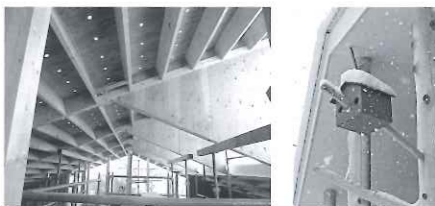
サンドイッチパネル工法（工事中）
