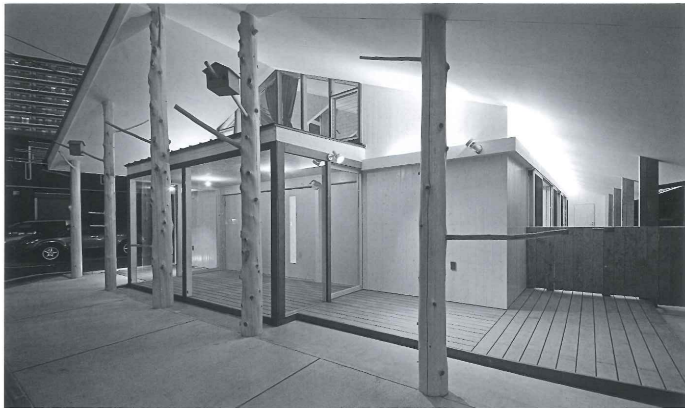
道行く人に覆い被さるように庇を大きく、その下のガラスの風除室は展示空間となる。小鳥の巣箱は、保育の象徴として作られたが、毎年、実際に小鳥が巣をつくって子供が巣立っている
