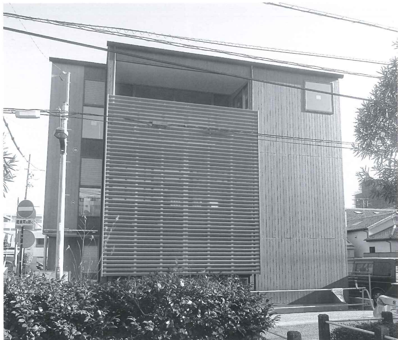
3階には、子どもたちのライブラリー+ワークスペースがあり、上の窓から吹き抜けを通じて公園を一望する。下の窓は、待ち合いカフェスペース、ルーバーは、居住空間のプライバシーを守り、光を導入するルーバー
