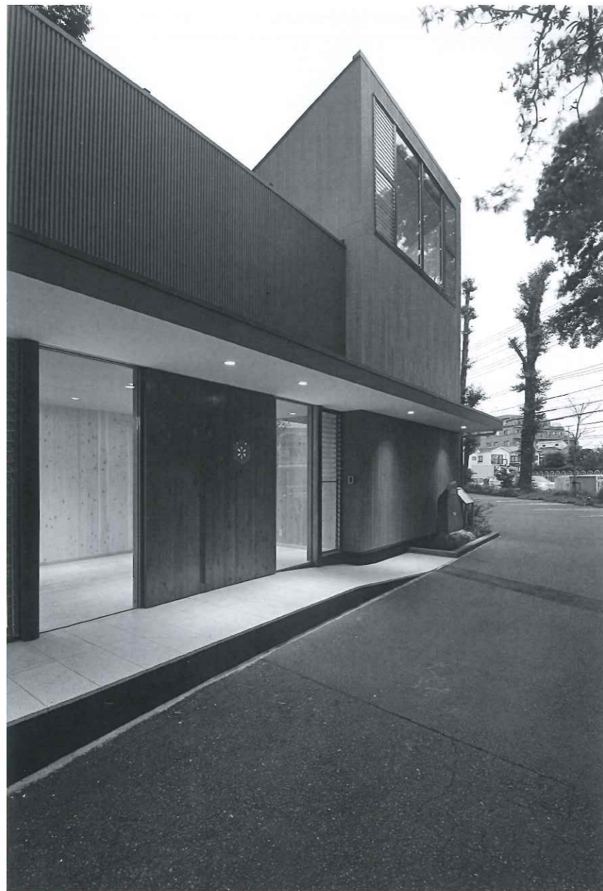
「御鳳輦舎」の破風飾りに、東京ガラス工芸研究所に依頼し、中世色のガラスをはめていただき、それを入り口の扉にはめ込んだ。入り口両側の丸柱も同建物の部材を便わせていただいた 写真：永石秀彦
