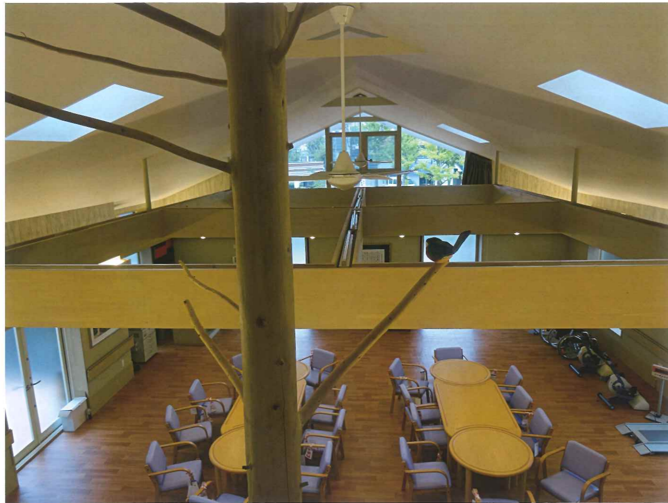
入り口には風除室はなく、バリアフリーで室内に入る。室内からはハイサイド窓やトップライトから空を望むことができる。欄間窓からは風が通る。森の中のイメージ
