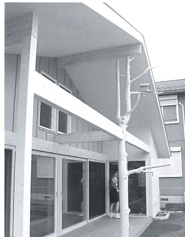
外壁はラージ合板、枝のついた柱は、至誠第二保育園の庭から寄付していただいた
