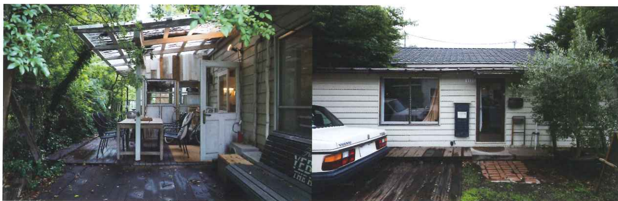
建物南側のテラス。室内とテラス間には段差がないため、リビングと一体化して利用される。
