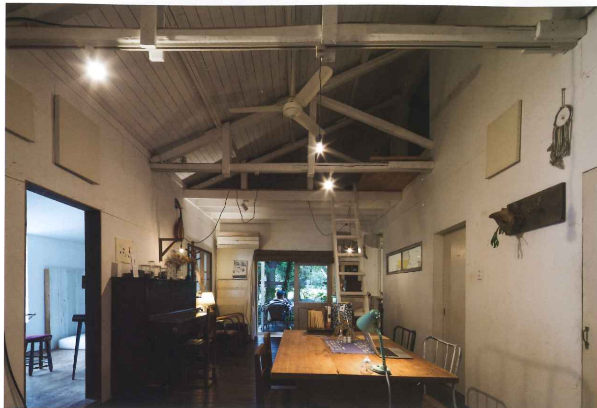
リビング兼喫茶店。奥はテラス。上部ロフトは住人による改修。トラスの小屋組みは当時のまま。
