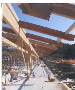
建て方：庇の跳ね出しはメガビーム
