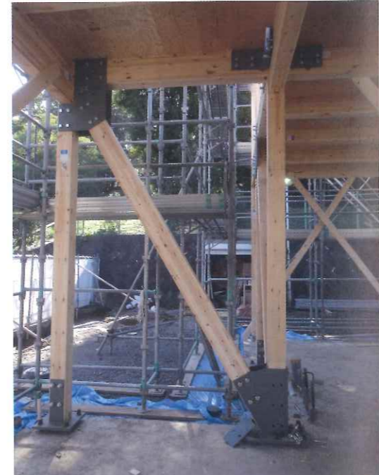
同様の構造形式は鉄骨造、コンクリート造でもつくられ、それぞれの躯体の合理性が検証された
