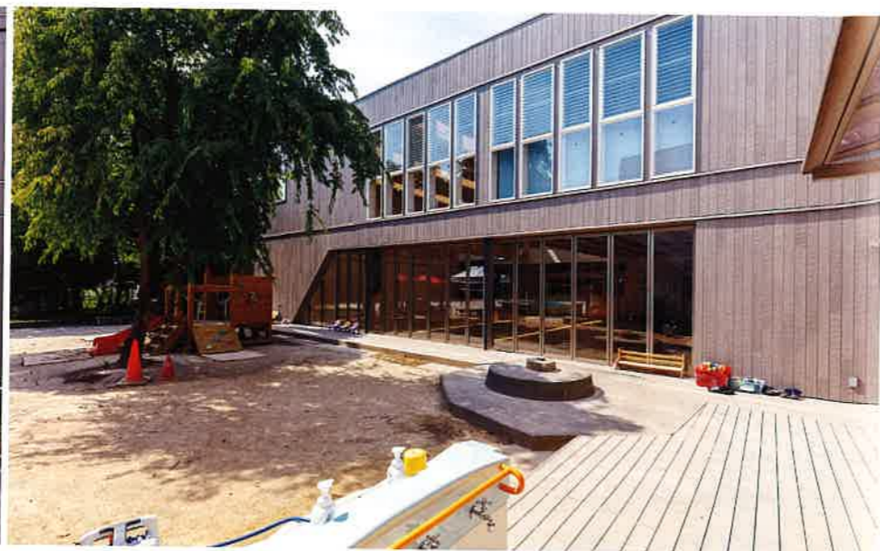
園庭より吹抜のホールを見る。サッシを全開にすると、内外部が連続し不思議な感覚の空間となる
