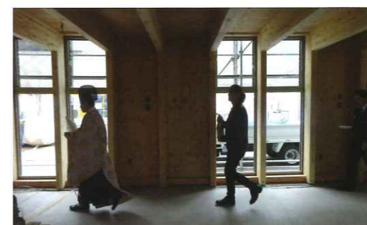
建て方がおわり、棟上げ式の場面。 長手方向に梁がなく窓がスラブ面まで到達している様子がわかる
