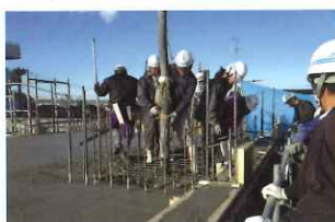
コンクリートの新設
