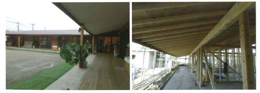
仮設園舎は、不等辺のT字型に建てられた。屋根材、木材、サッシなどほとんどが解体されマダガスカルへ送られた。
