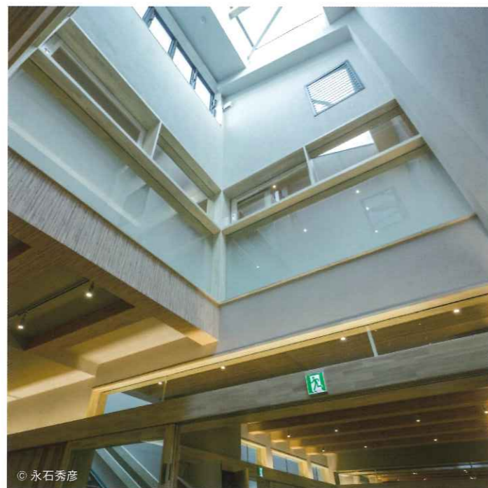
「風と光の塔」屋根から1階に光をそそぎ1階の熱を煙突効果で屋根から廃棄する
