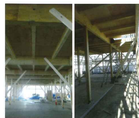
床の合板はt28 ラーチ合板
