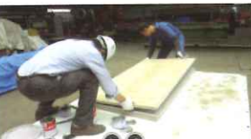
SW パネルの製作
