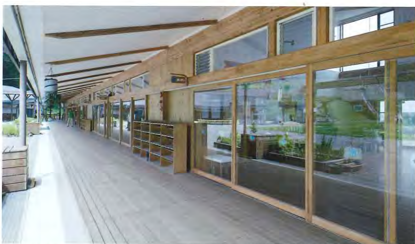
縁側。保育室同士の行き来は室内でも可能。左の円筒は柱のようにみえるが、屋根に降った雨水を貯める配管である。庇は特殊な超高剛性の梁で片持ちの構造
