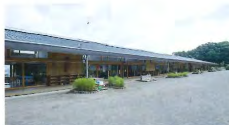
保育室棟外観。外と内との連続性を重要視して考えられた形である。屋根には太陽光発電パネル
