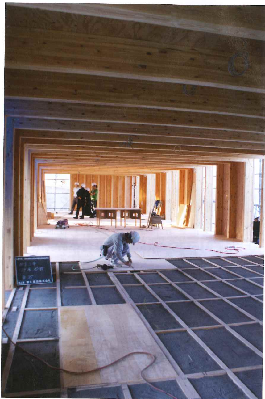
調布白菊幼稚園では、遮音性を高めるために2階の床下に砂を入れている 蓄熱性も高く、アメリカでは広く見られるが、日本では珍しい仕様である
