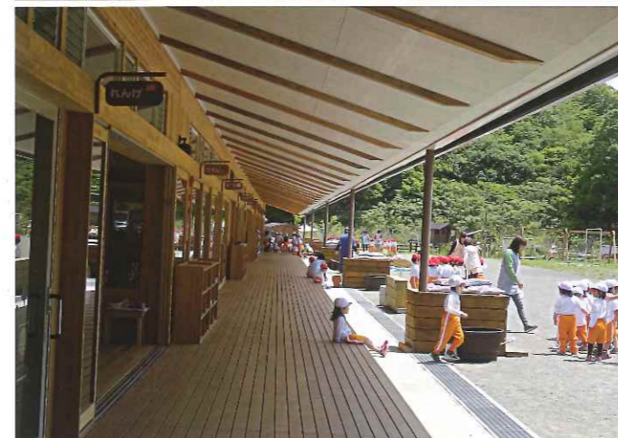
上 | 木造在来工法による大空間 下左 | 特殊LVLにより、3.6mはね出した庇 下右 | 親子で楽しめる図書・カフェスペース
