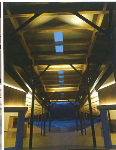
独立柱で支えられる庇
