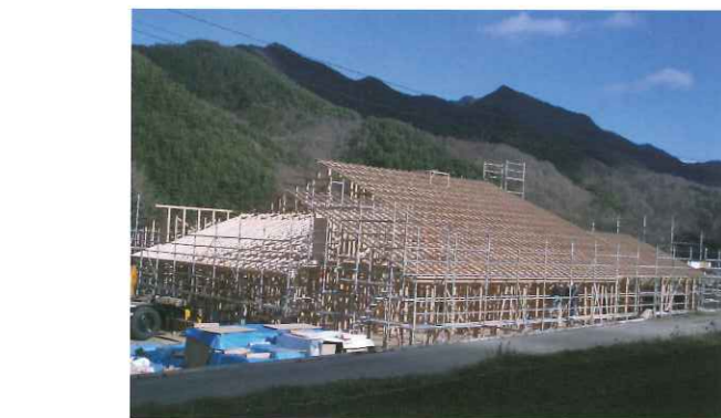
写真7 建築中の南相木村高齢者支援施設。3月竣工予定
