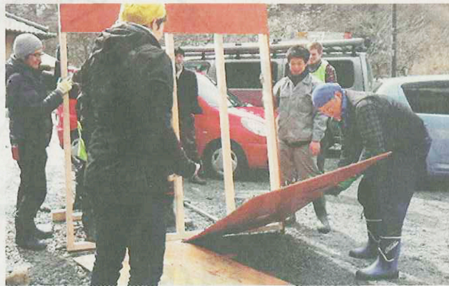
川崎市で形を整えた部材パネ ルを現地で組み立てる人たち
