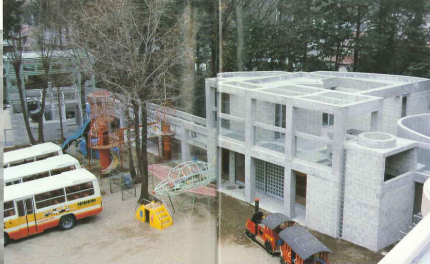
ゲート棟外観
