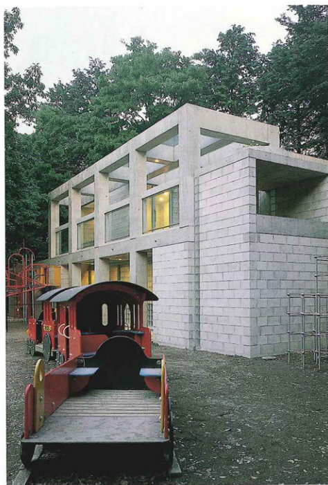
西より見る。外壁：コンクリートブロック撥水剤塗布，コンクリート打放し。
