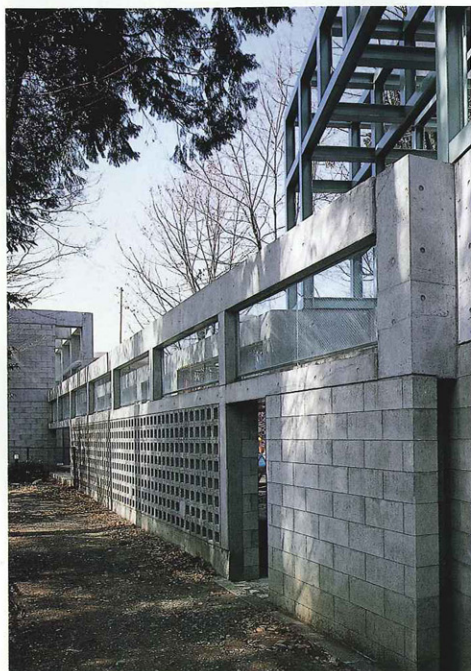
南よりブリッジを見る。下部は南側の緑が見えるように穴開きブロックが積まれた。
