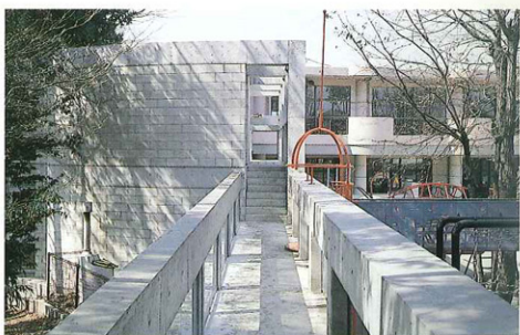
ブリッジより本館方向を見る。
