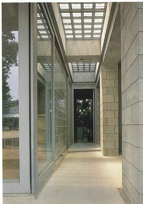
役員控室変越しに南の緑を見る。ガラスブロックのトップライトによって採光を確保している。
